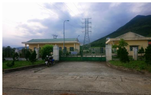
Ảnh 23: Nhà máy cấp nước sinh hoạt thị trấn Tân Uyên
